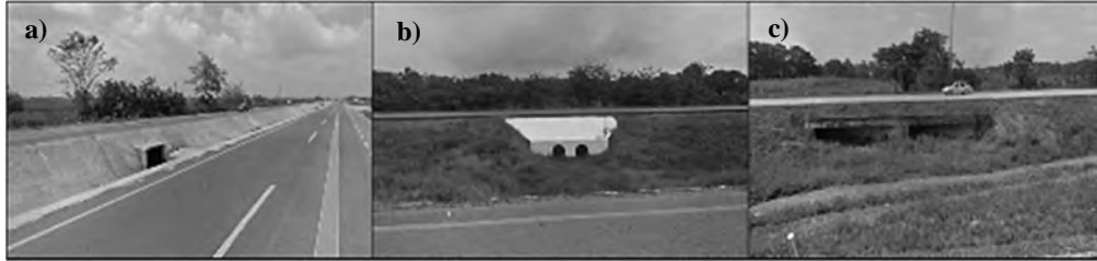
Figura 4.- Obras de drenaje de la Carretera Villahermosa-Coatzacoalcos. a) Cajón de drenaje. b) Tubo doble. c) Losa doble de drenaje
